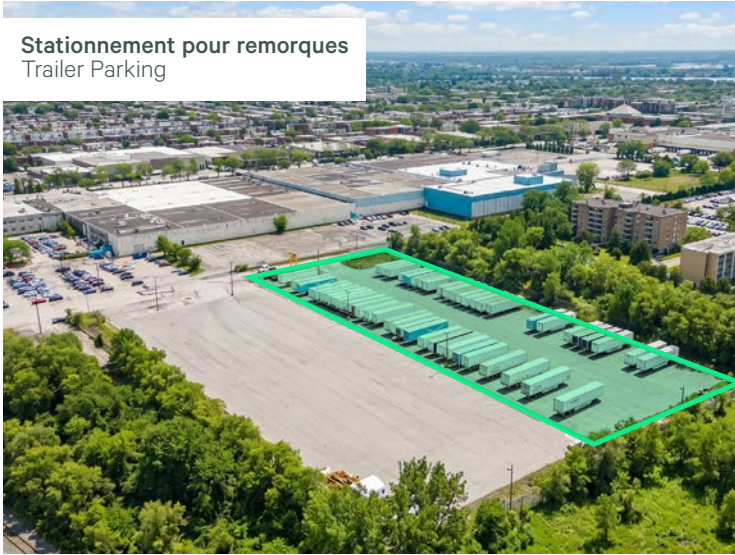
Stationnement pour remorques Trailer Parking
